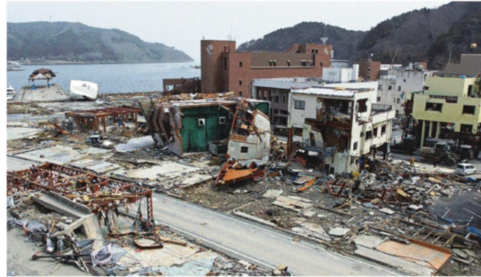
津波に襲われた七十七銀行旧女川支店周辺(平成23年3月20日、宮城県女川町)
