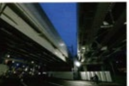
完全高度化された竹ノ塚駅の踏切。踏切が無く、歩行者や自転車は電車の通過を待たずに通行できるようになった。東京都足立区で2022年4月27日。佐々木晴一撮影
