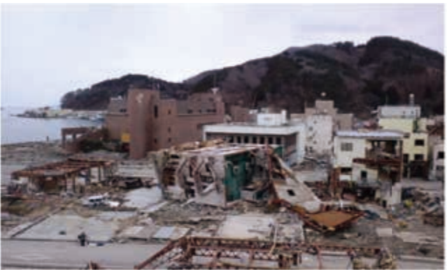
(写真2) 七十七銀行女川支店(横倒しになった建物の奥に建つ建物、2011年3月22日撮影)
